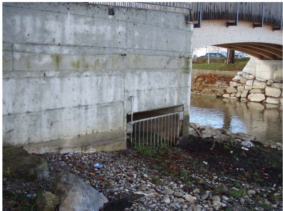
Abbildung 8: Notauslauf Entlastungsbauwerk RU 0190
