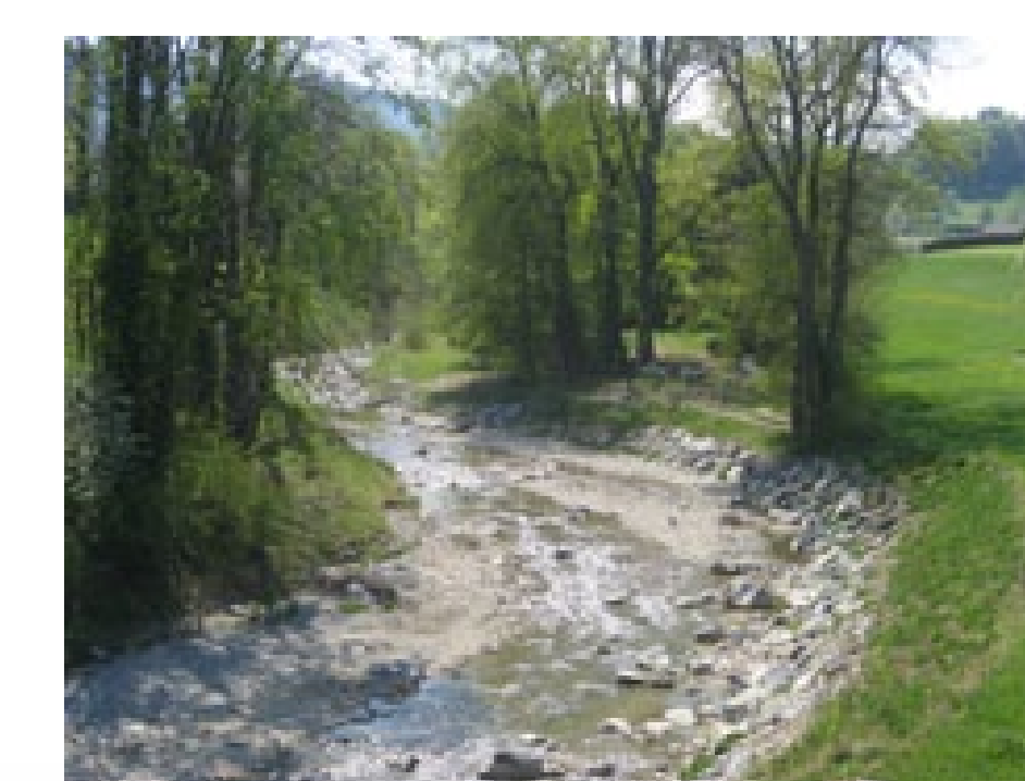
Kürzlich naturnah sanierter Gewässerabschnitt mit Kiesbänken auf der Innenkurvensseite, altem Baumbestand als Schattenspendender und sonniger Prallhangböschung als Lebensraum für viele Insektenarten.
